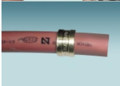
Colocar el casquillo en el tubo deslizándolo lo suficiente para que no moleste durante el montaje.
