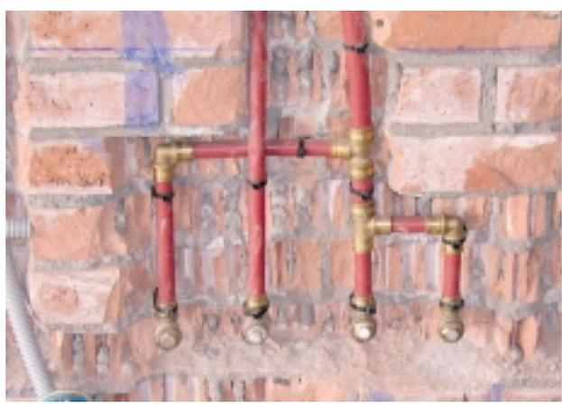
**INSTALACIÓN POR ROZA / REGATA CON LA TUBERÍA EMBEBIDA (MORTERO - HORMIGÓN - YESO)**
